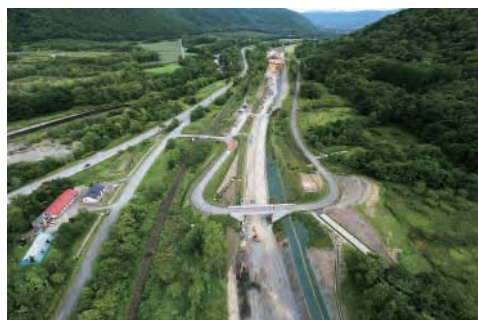
工事状況撮影(遠軽町)
